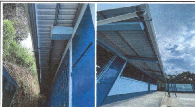
Foto 3 Sustitución de canales de PVC por canales galvanizados.
