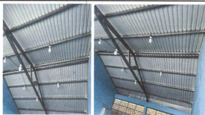
Foto 2 Sustitución de soportes por costaneras galvanizadas.
